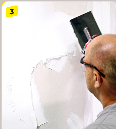
3 Die Spachtelmasse wird mit einem Glätter auf die vorgrundierte Wand aufgetragen.
