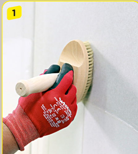
1 Die Wand muss frei von Staub und losen Teilen sein. Am besten grundiert ihr dazu die Fläche, z. B. mit dem Universal Tiefgrund LF.
