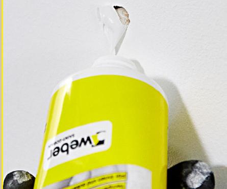
Die Spackelmasse wird direkt aus der Tube auf die zu füllende Fläche aufgetragen.
