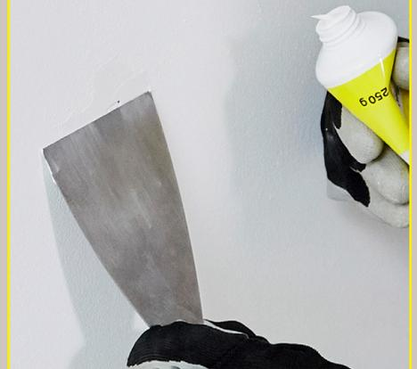
Abschließend wird die Spackelmasse flächenbündig abgezogen.
