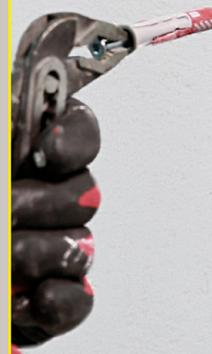
...und diese anschließend mit einer Zange herauszieht. So kommt der Dübel ganz leicht aus der Wand.
